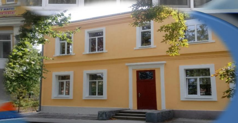
Ремонт фасаду ДНЗ № 396
